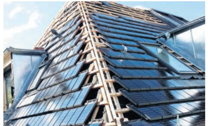
Solarprodukte von Autarq basieren auf Tondachziegeln und bleiben optisch zurückhaltend. FOTO: AUTARQ
